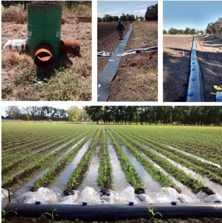
*Figura 7: Imágenes del proceso del armado, instalación y funcionamiento de la manga de riego.*
