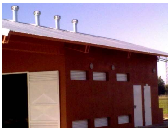
Figura 7: Vista del depósito de agroquímicos de la EEA San Pedro con sus ventanas ubicadas a distintas alturas y en el techo, para favorecer la ventilación natural. (Fuente: Paunero, I.)
