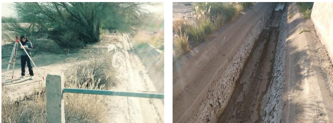
Figura 2: Canal Colonia Fiscal a la altura de los aforos
