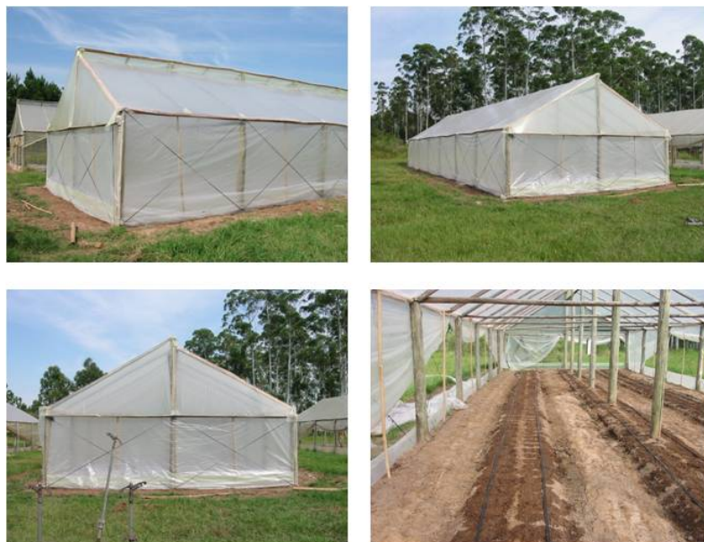
Figura 3.1: Invernadero tipo capilla a dos aguas con ventilación cenital usado en el ensayo experimental.
