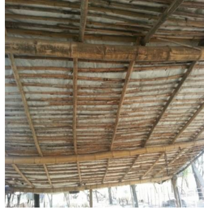
Foto N° 13: Estructura de caña
