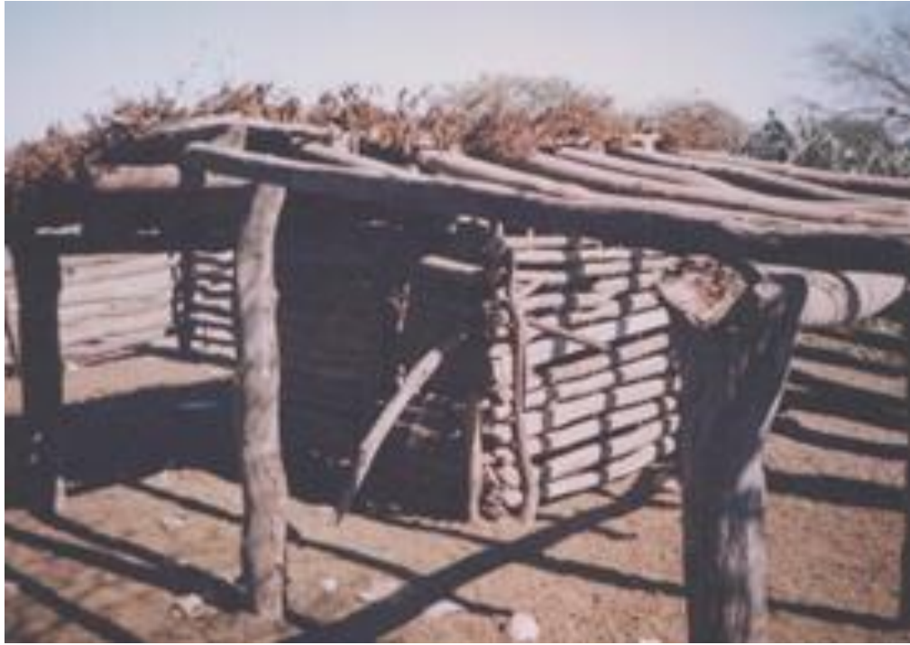
Foto N° 4: Guacheras pequeñas y sin limpieza
