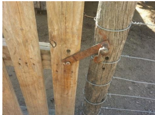
Foto N° 15: Pasadores para las puertas
