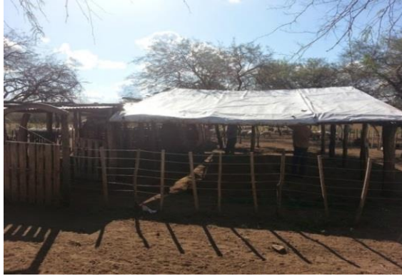
Foto N°12: techo de caña hueca y plástico de silo
