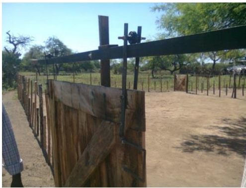
Foto N° 14: Adaptación de puertas corrediza, con materiales de la zona
