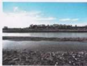
Foto 11. Desde la banda de la comunidad mirando al Norte. Se observa una extensa defensa edificada con desecho de arciles, de unos 5 m de altura, que defiende las instalaciones de la empresa Minerosubia.
