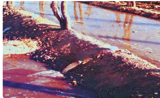
FOTO 07 Instalación de tubos a nivel.
