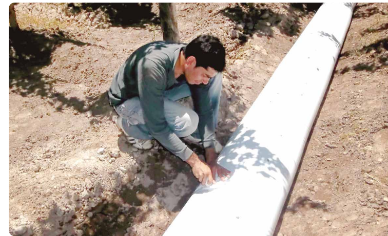
FOTO 08 Instalación de campo.
