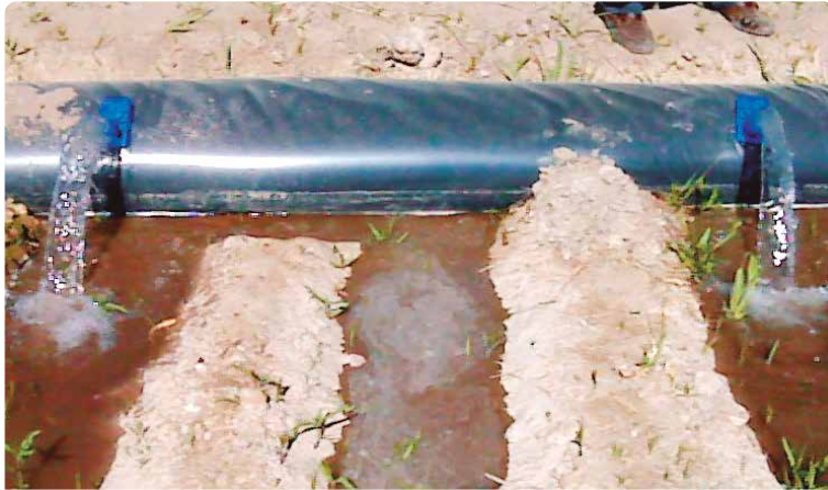
FOTO 10 Detalle de compuertas
