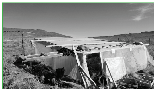
Figura 4: Invernadero con piedras para evitar la voladura
