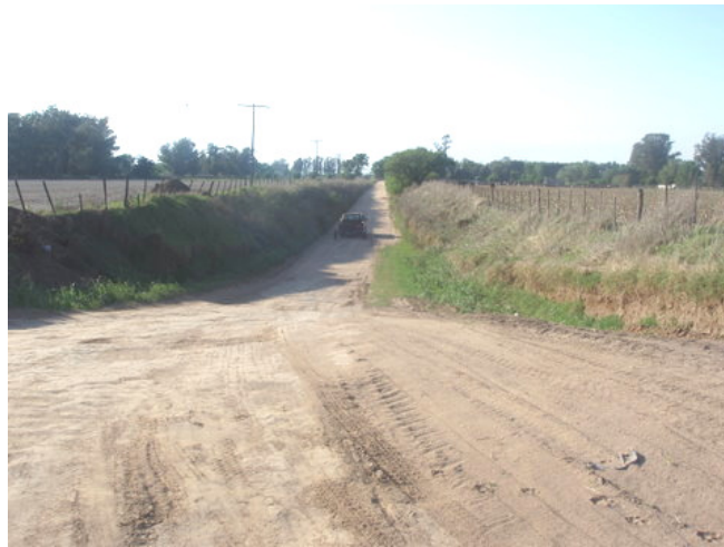
Figura 3. Camino por debajo del rasante del suelo
