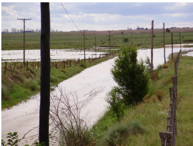
Figura 2. Camino intransitable por efecto de la erosión hídrica
