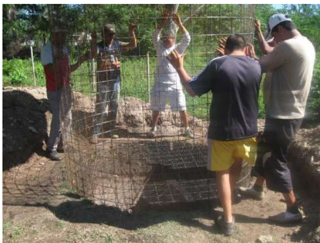
Ilustración 1 Construcción grupal de cisterna
