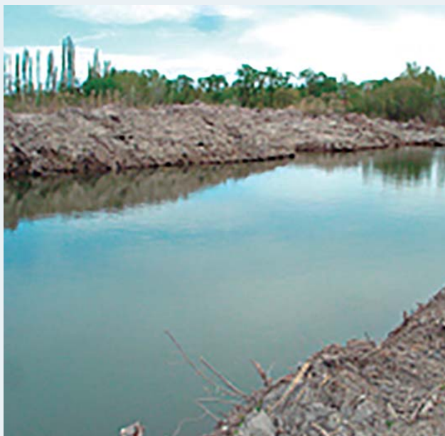
Reservorio conectado a un drenaje
