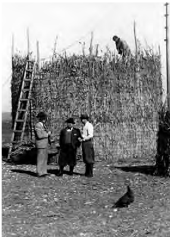
Construcción de silo en región pampeana (s/f) (Izq.)
