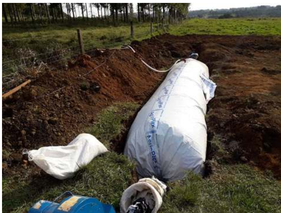
Foto1. Biodigestor de silo bolsa.
