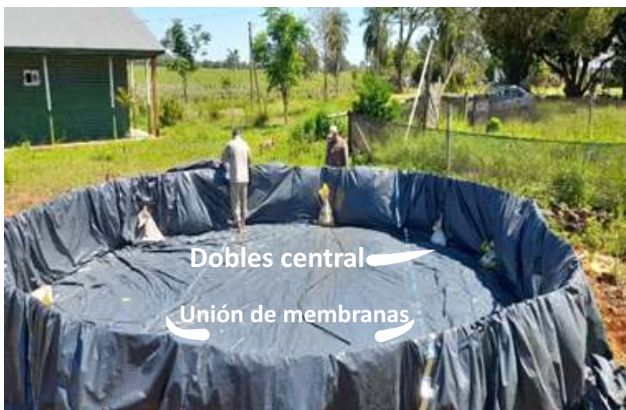
Foto 3. Centrado del polietileno y colocación dentro de la malla
