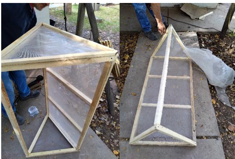
Figura 3. Colocación de tela mosquitera en la base y laterales.
