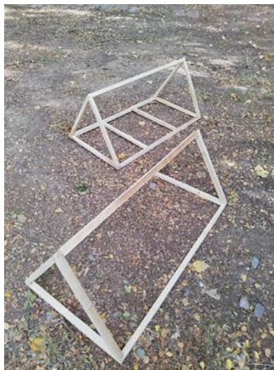
Figura 1. Armado de la base a dos aguas.
