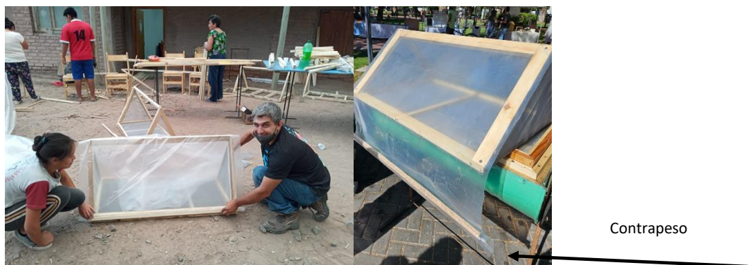
Figura 4. Colocación del nylon para formar un techo a dos aguas – costado móvil con contrapeso.
