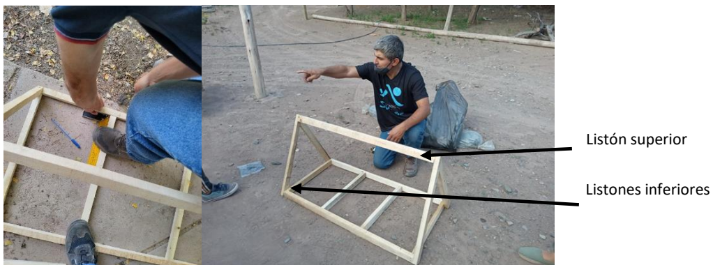
Figura 2. Colocación de listones inferiores y superior (base).
