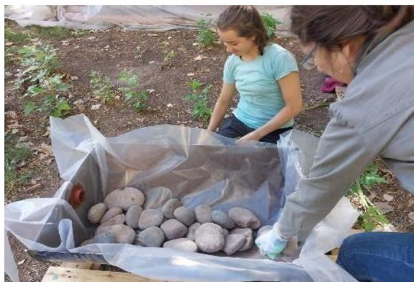
Figura 13. Colocación de nylon y piedra bola en los tachos del humedal.
