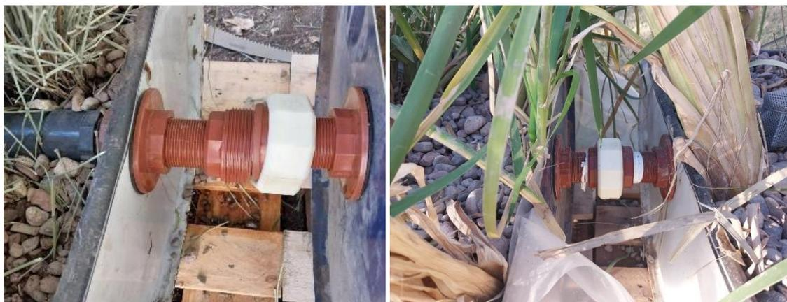
Figura 9. Unión de ambos tachos mediante “unión doble”.
