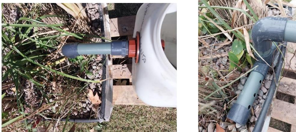
Figura 10. Caída de agua del desgrasador al primer tacho.
