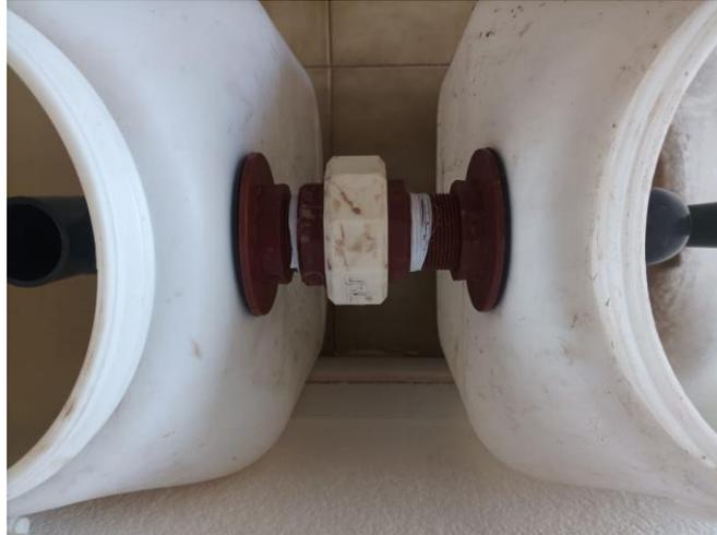
Figura 8. Envases unidos mediante “unión doble”.
