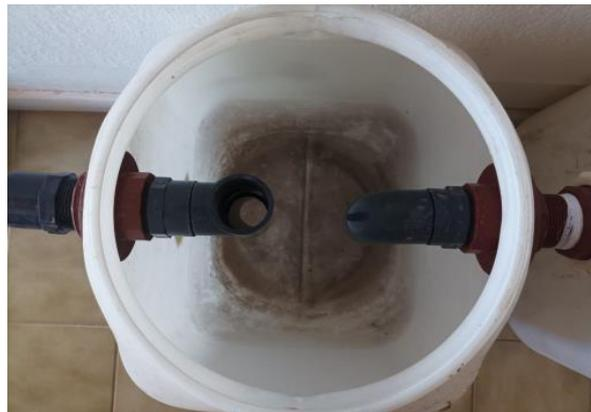
Figura 5. Segundo tanque con dos orificios y dos “unión de tanque”
