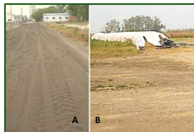
Figura 17-1 A) Camino de acceso al área de almacenaje de subproductos, protegido con arenas de fundición. B) Piso compactado y arenado en sector de acceso al silo bolsa, e incluido el propio suelo del silo bolsa para extraer en días de lluvias o temporales. (Fuente: INTA Rafaela).
