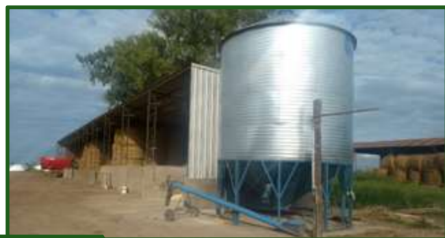
Figura 17-3 Uso de boxes o galpones con compartimentos, de tal manera de tener almacenados y disponibles los distintos subproductos en este sitio y poder cargarlos directamente con la carga frontal.
