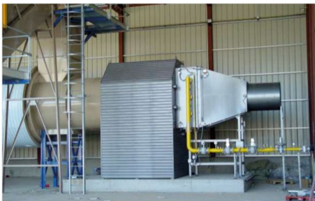
■ Figura 17. Quemador de gas conectado al extremo del tromel. Imagen de un modelo de la firma AYPE, España. Foto: gentileza Apisa S. L., España.
