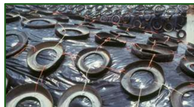
Figura 10-49 Cubiertas de auto cortadas al medio y debidamente colocadas y unidas entre sí.
