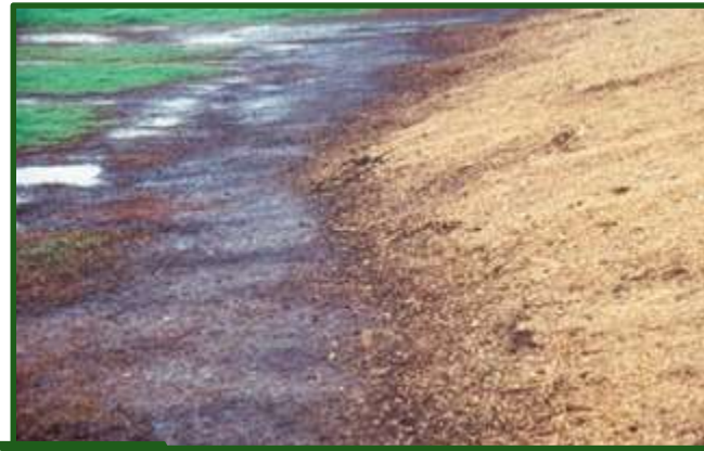
Figura 10-16 Efluentes perdidos en un silo aéreo, con alto nivel de humedad.
