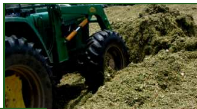
Figura 10-31 Cuando se baja demasiado la herramienta de desparramado o cuando no hay potencia suficiente se puede producir patinaje, creando zonas de baja densidad en el silo.
