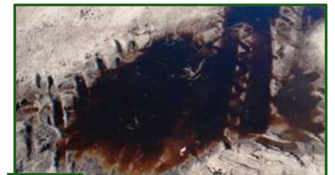
Figura 10-36 Pérdidas de efluentes en un silo de grandes dimensiones y detalle de líquidos perdidos.
