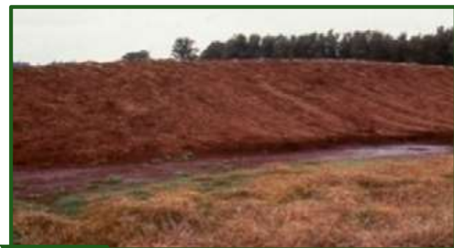
Figura 10-37 Sistema de drenaje en el lateral de un silo de grandes dimensiones.
