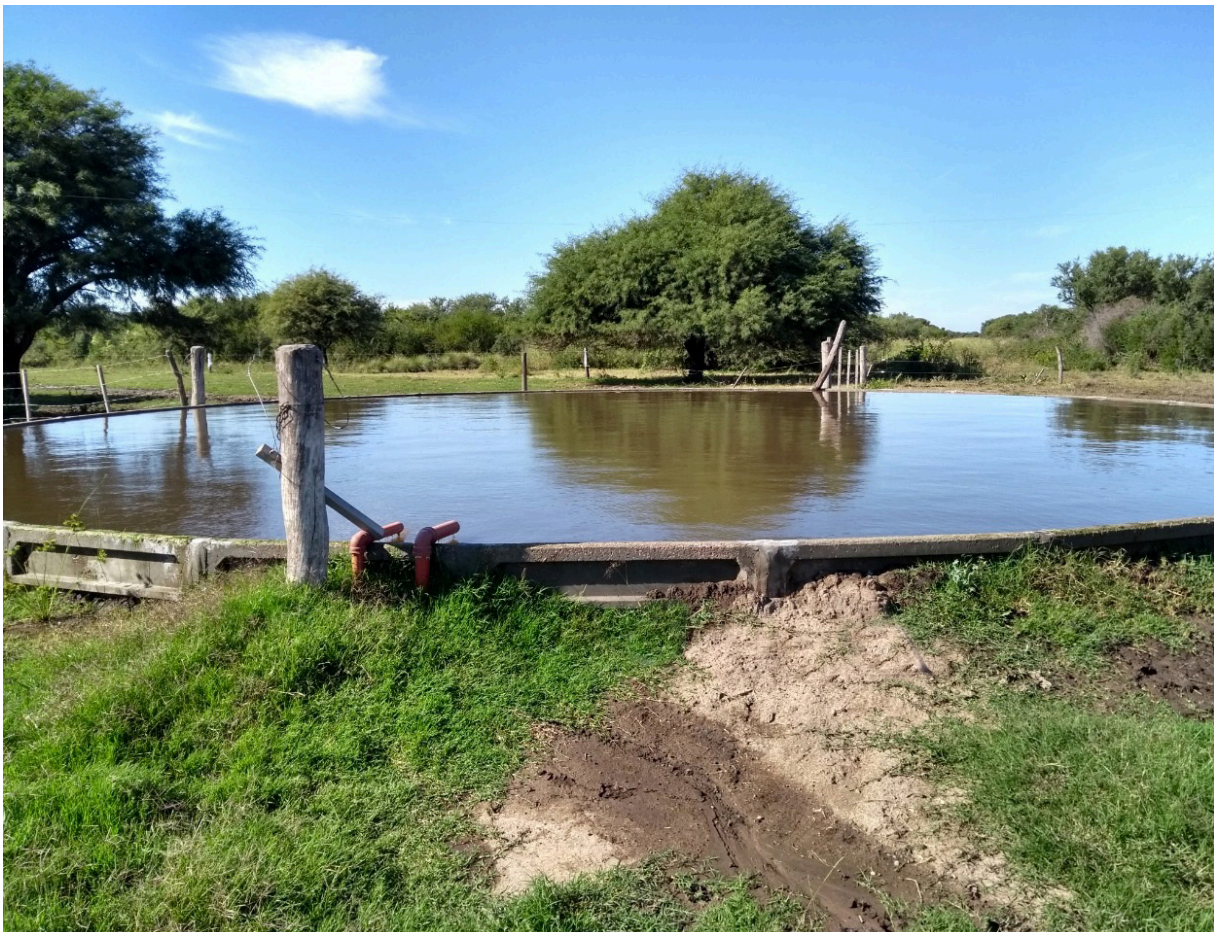
Tanque doble propósito: reservorio y bebedero
