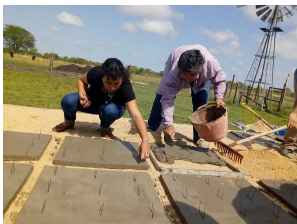
Figura 3. Mujeres de la comunidad Obraje San Juan construyendo aljibe de placa. Norma Cardozo, Hilda Aguirre. Villa Guillermina.
