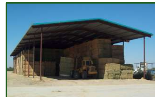
Figura 9-19 Megafardos estibados en tinglado.
