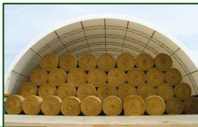
Figura 9-21 Heno bajo estructura cubierta de nylon, muy utilizada en EEUU.
