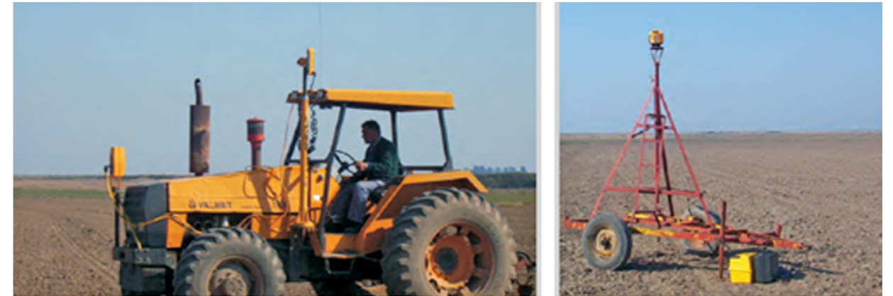
Figura 22. Marcación de taipas con nivel láser.
