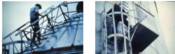
Figura 9. Tipos de escaleras recomendadas en silos
