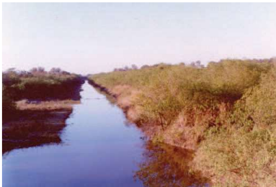
Serie Iporá Guazú. Este canal elimina los excesos de agua proveniente de las lluvias. (Foto Equipo de Suelos).
