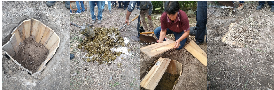
Imagen 5: Pozo con paredes laterales recubiertas de madera, mezcla de bosta con minerales y mezcla en el pozo con tapa.
