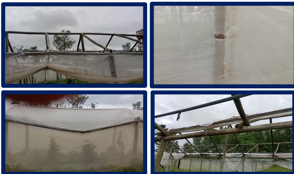
Figura 6. Rotura total de invernáculo de multiplicación de guías de batata a raíz de la tormenta ocurrida el 29 de diciembre de 2023.
