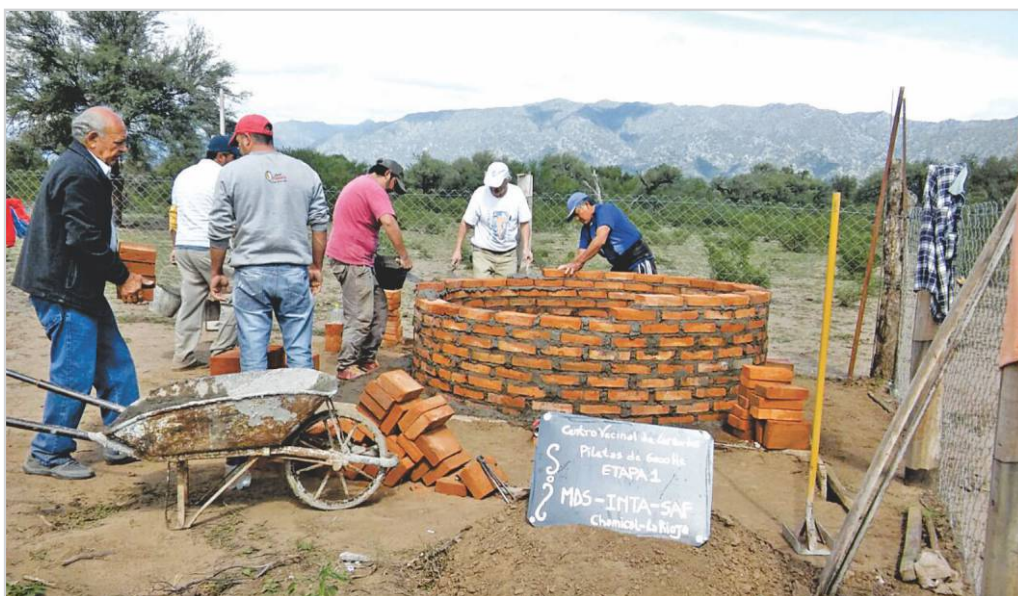
Construcción de reservorio de agua en la comunidad de Los Bordes, dpto. Chemical.
