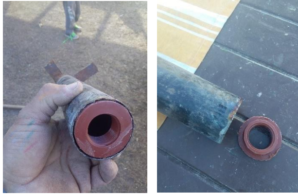
Figuras 8 y 9. Cortado de la unión de tanque con un hierro caliente.
