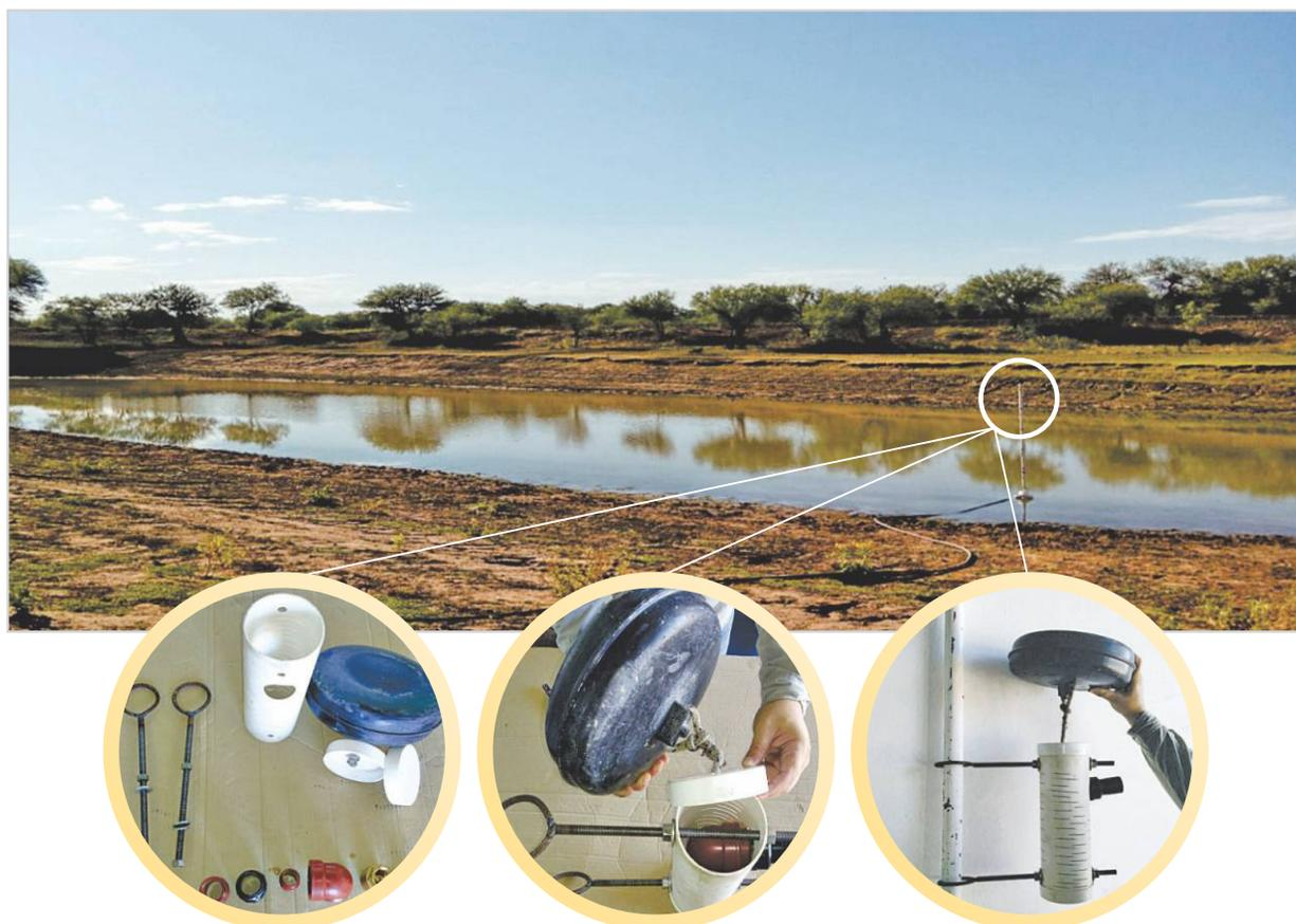
*Figura 5. Detalles chupador flotante represa Esquina del Norte.*
