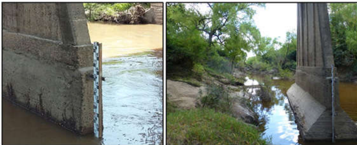
Figura 3. Regla-Escala instalada por la DHER bajo puente sobre Ex Ruta Provincial N° 50, cercana al punto de muestreo 4.
