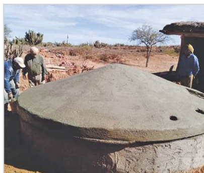
Finalizando la construcción de cisterna.
