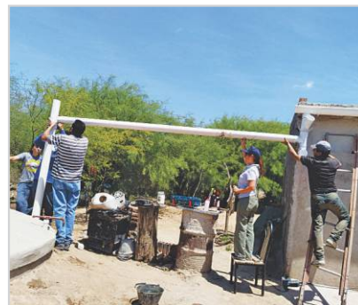
Instalación de sistema de recolección de agua (Tomasía Díaz de Moreno).
