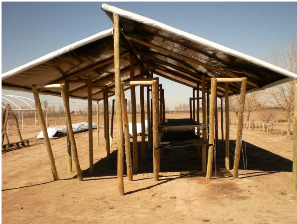
Figura 2. Vista frontal de un secadero vertical de madera (ver al centro/derecha modificación para secar aromáticas)
