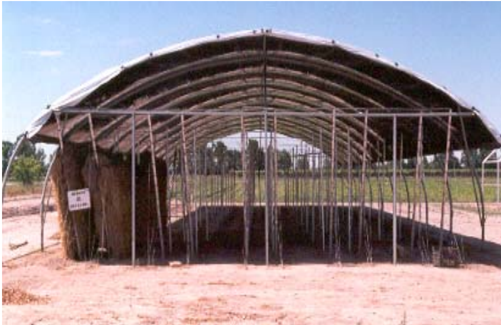
Figura 1. Vista frontal de un secadero vertical metálico (ver carga en el sector izquierdo)
