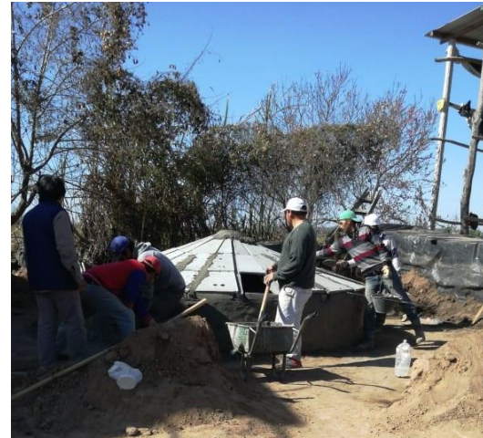
Construcción de Cisternas de Placas realizada por los productores integrantes del grupo.
