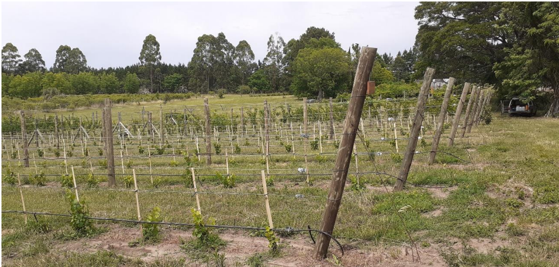
Imagen 5: vista de los postes, alambres, riego y estiradores.
