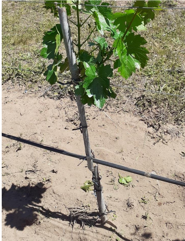
Imagen 9: Instalación del caño de riego con goteros incorporados
