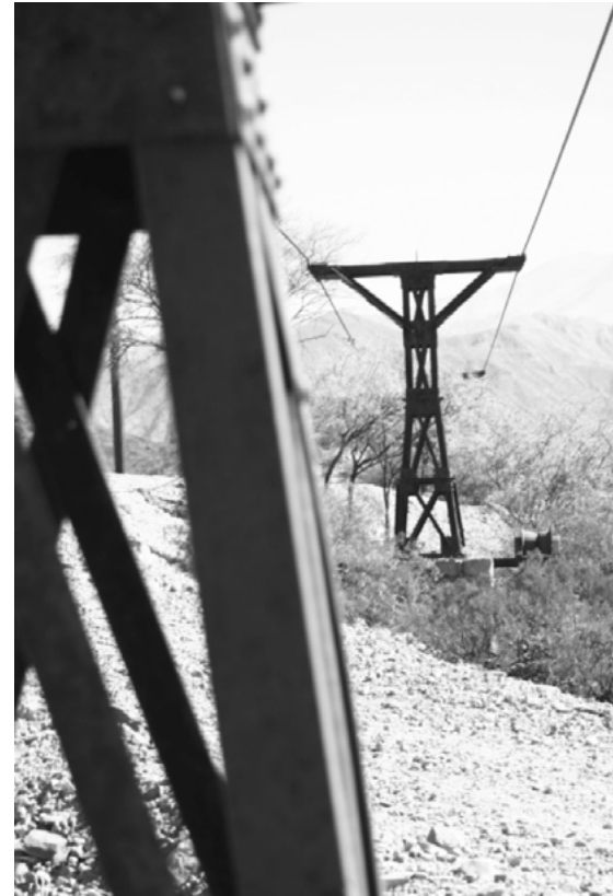
Figura 4.9. Cablecarril que funcionó con leña para el transporte de minerales de las minas de Famatina (Chilecito, La Rioja) hasta principios de siglo XX (Agalón Productora 2010).
