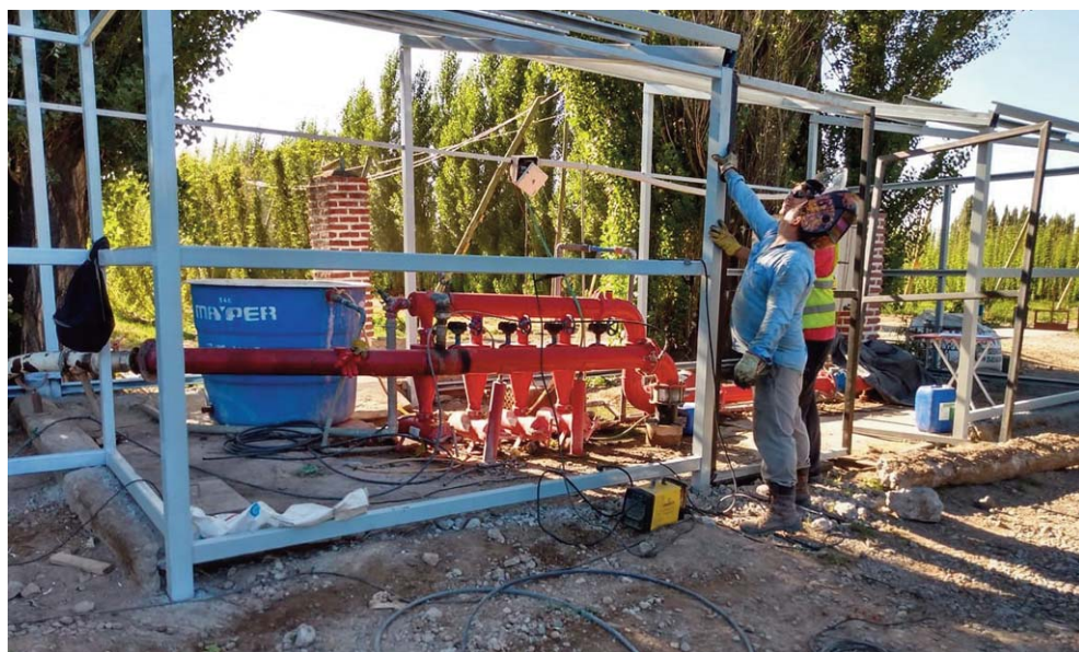
Foto 43. Instalando equipo de fertirriego en lupular. Alto Valle del río Negro.
