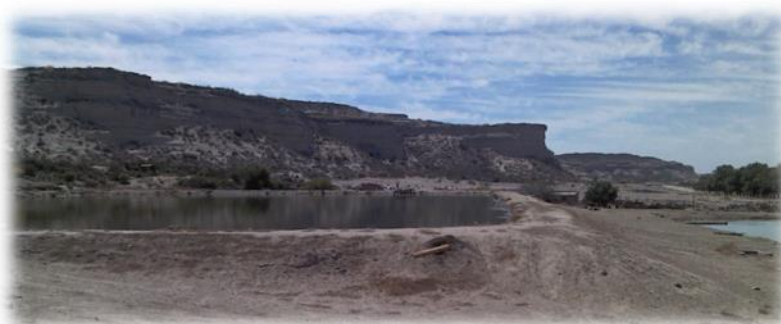
Piletas de Oxidación para tratamiento de líquidos cloacales.
