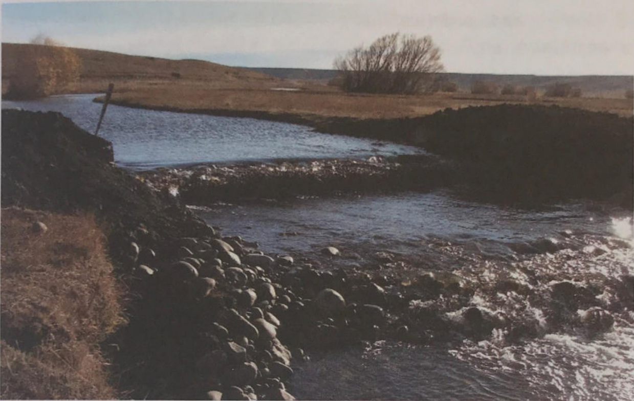
Figura 14. Azud nivelador sobre el cauce principal del río Coyle – Ea. Ruben Aike – Sur de la Provincia de Santa Cruz.
