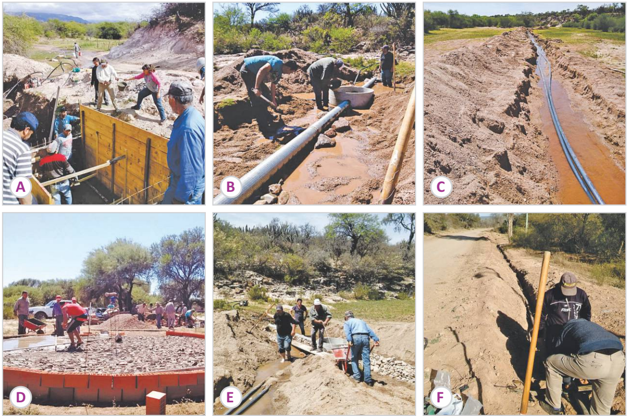
Figura 2. Trabajo de manera conjunta con la comunidad en: instalación del dren (B y E), construcción de cámara colectora (A), construcción de pileta comunitaria de 40.000 litros (D) y tendido de cañerías hacia los domicilios de las familias (C y F).
