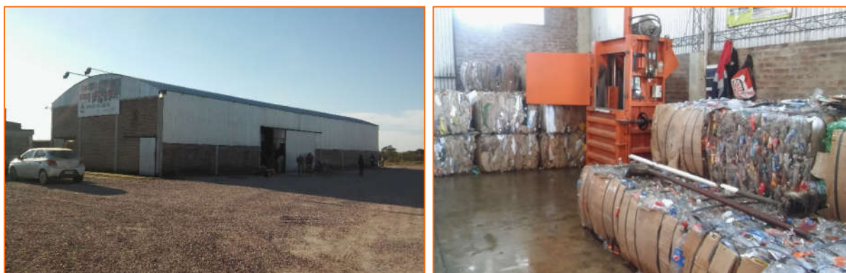
Figura 7. Planta de Tratamiento de Residuos Sólidos Urbanos y material prensado para la venta.
