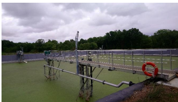
Figura 1. Planta de tratamientos de uso colectivo
