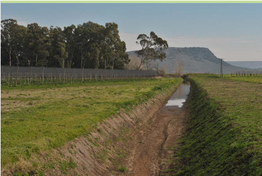
Figura 6. Canal de desagüe para evitar encharcamiento del suelo.
