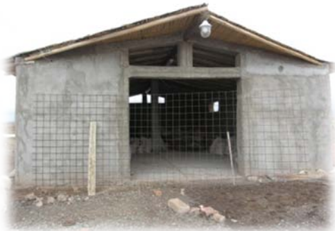
Una de las últimas sedes en construcción, cooperativa "Los Tréboles"
