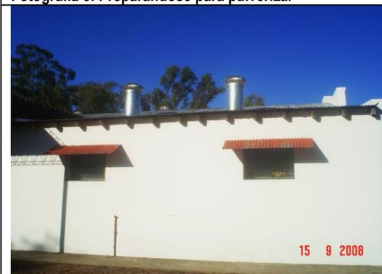
**Fotografía 5: Ventilación depósito de agroquímicos.**
