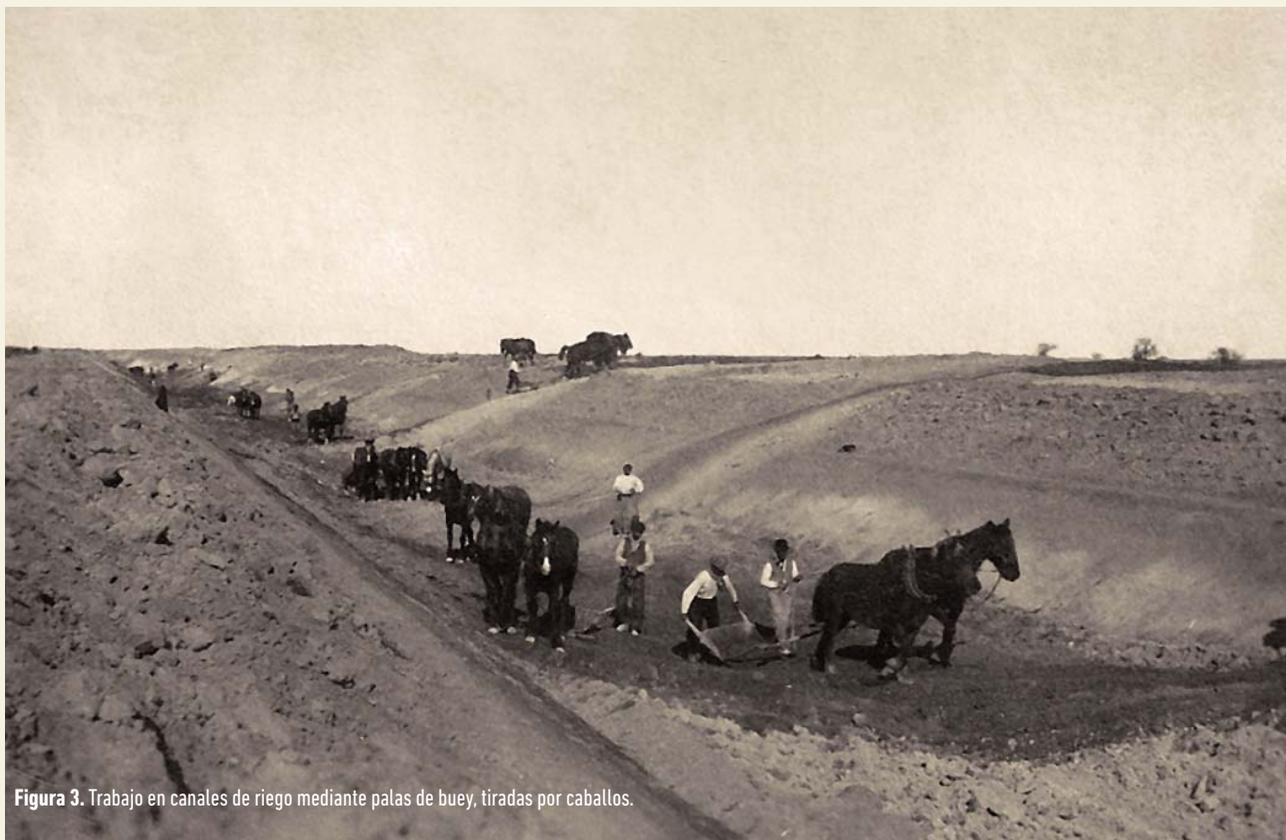
**Figura 3.** Trabajo en canales de riego mediante palas de buey, tiradas por caballos.
