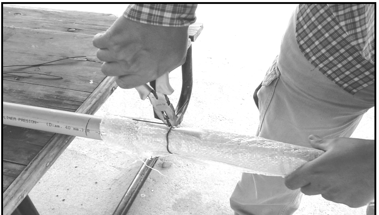
Fig.3 Tela protectora terminada en la zona del filtro
