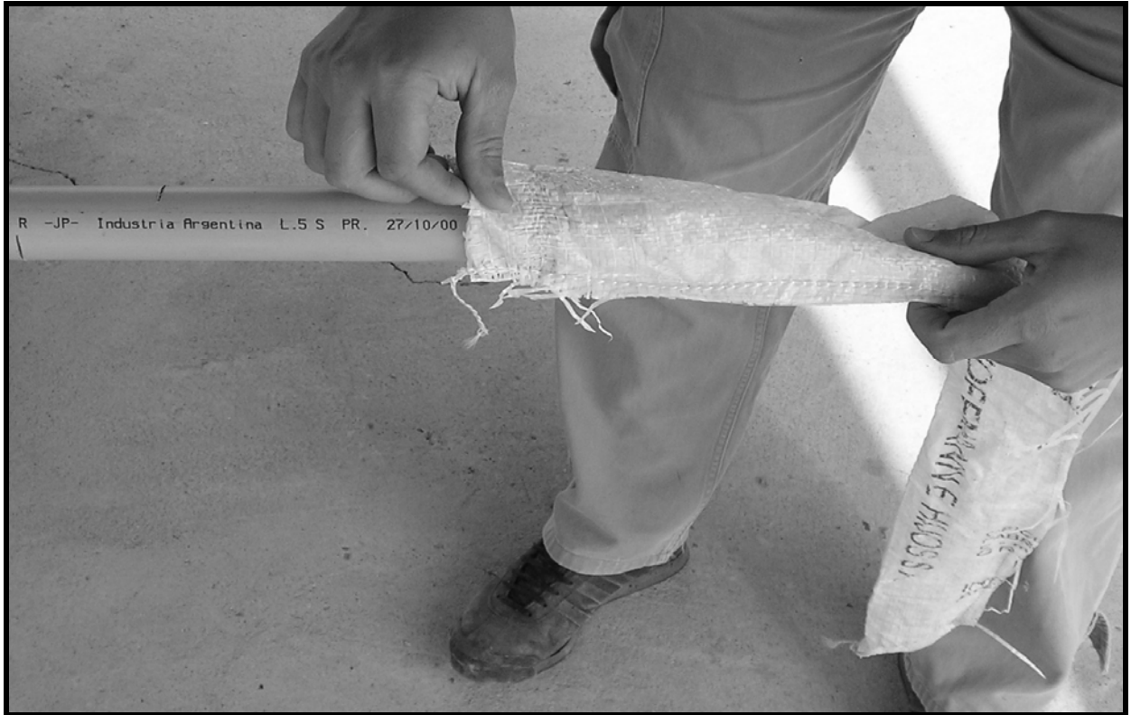
Fig.2 Colocación de tela permeable protectora
