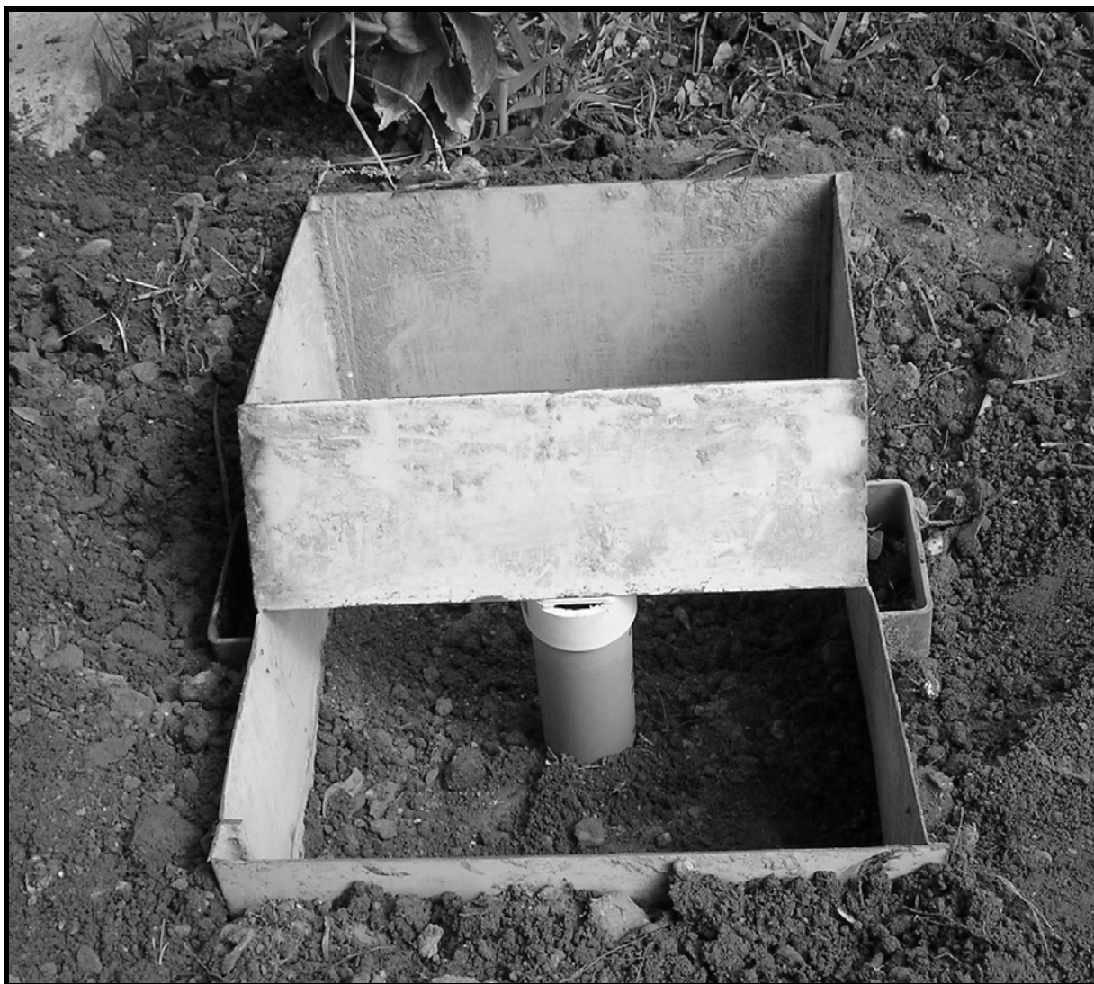
Fig 5. Freatímetro y molde colocado y preparado para la base de hormigón
