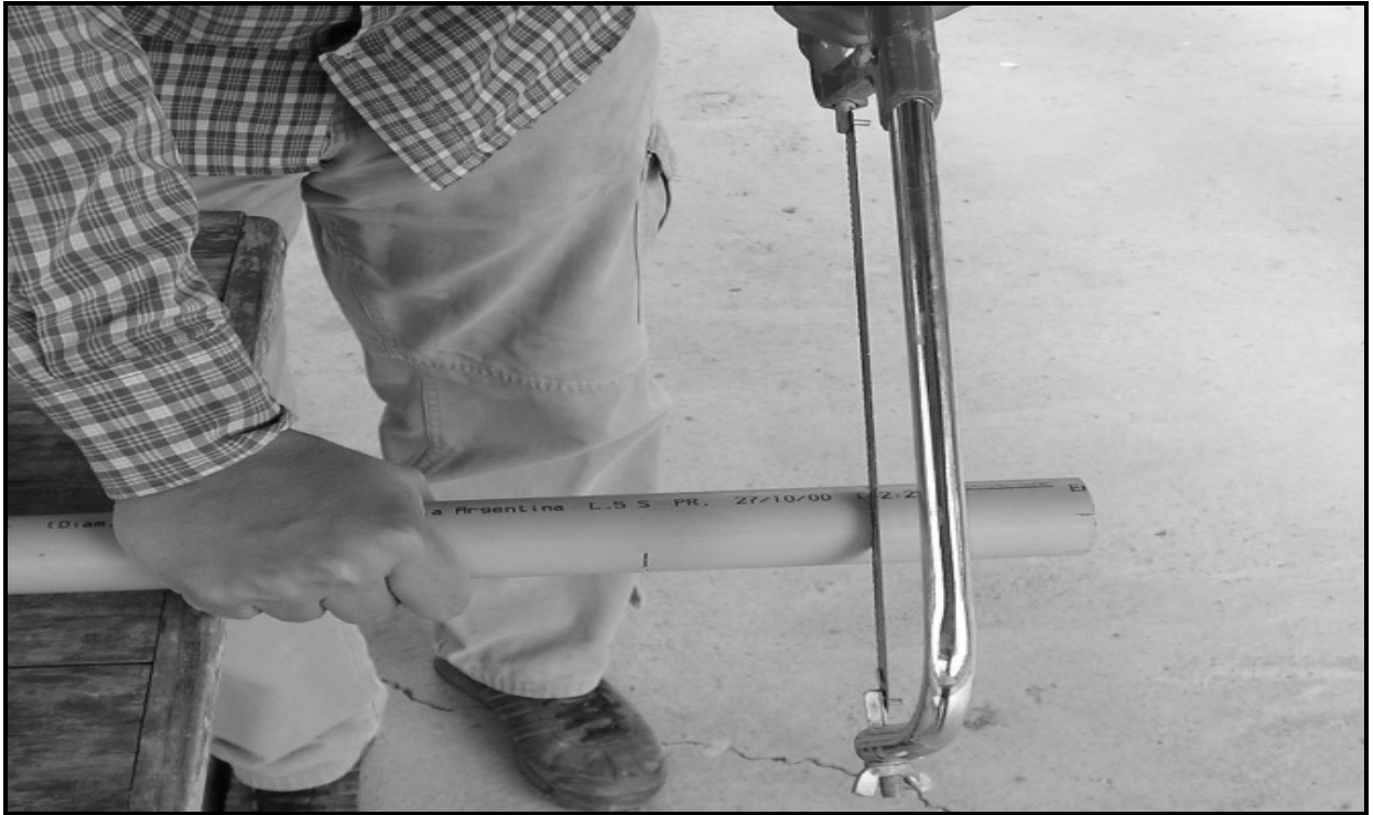
Fig. 1 Ranurado del freatímetro en la zona del filtro
