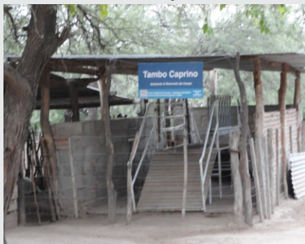
Local de extracción de leche con pared de 1,5 m
