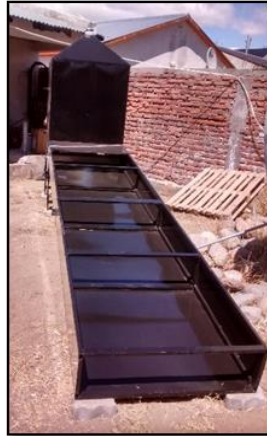
Figura 9: Revestimiento del colector con chapa negra y pintura.
