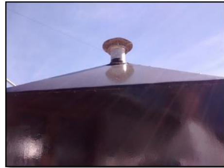
Figura 17: Sombrero de la chimenea.
