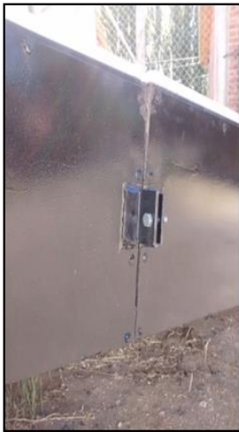
Figura 10: Unión de las dos partes del colector, con planchuela ángulo de 4 cm.
