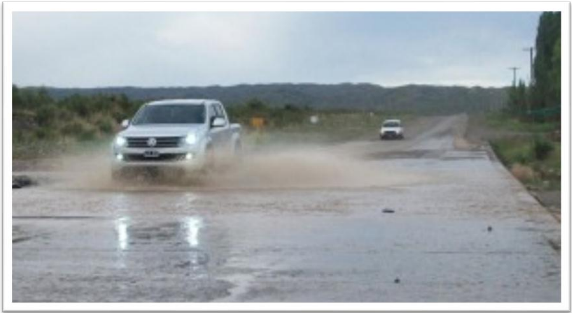
Figura 12. Anegamiento de parte del “Camino a Colón” luego de una lluvia.
