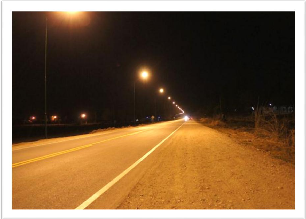
Figura 11. Alumbrado Público instalado en el tramo de la Ruta Provincial N° 24 que conecta la circunvalación con el empalme a la ruta, camino a Paraje Las Blancas.
