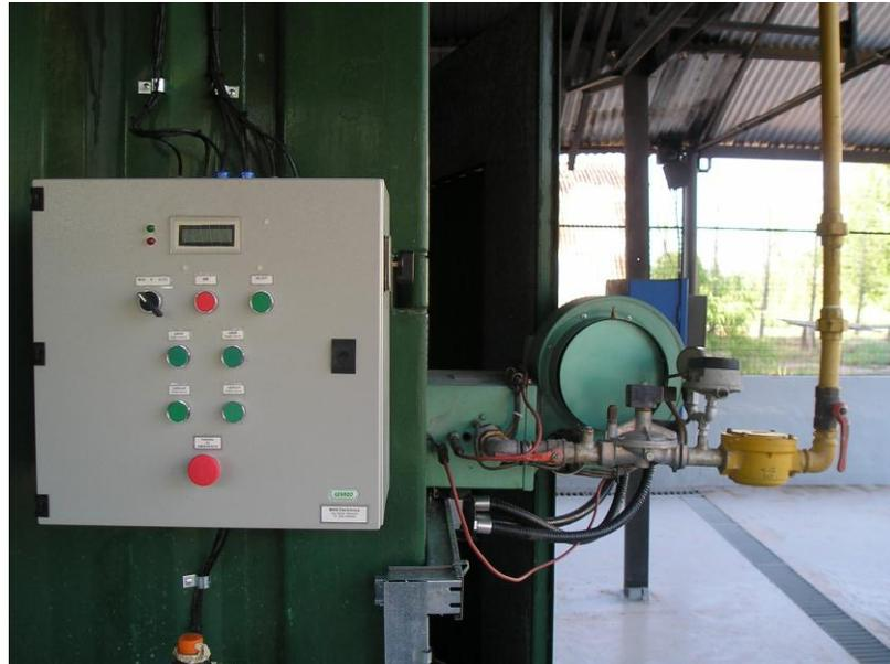
**Figura 3.3 Detalle del quemador, Planta Piloto de Deshidratado de Frutas EEA Rama Caída.**
